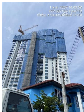
รูปที่ 70 ติดตั้ง Mesh Sheet ตลอดความสูงของอาคาร
