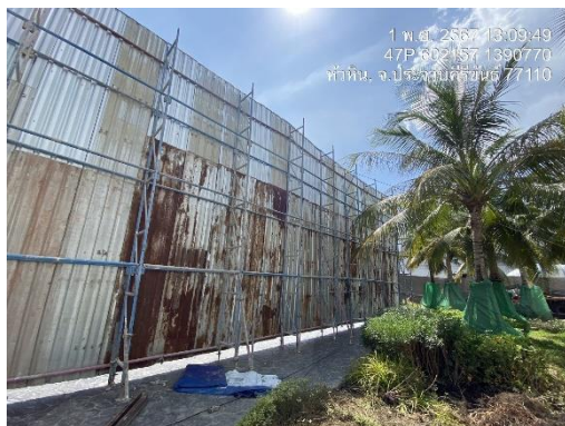
รูปที่ 1 ติดตั้งรั้ว Metal Sheet รอบพื้นที่โครงการ
